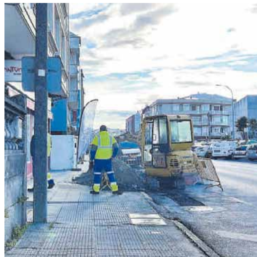
Operarios trabajando en la red soterrada de Rodeira. | S.Á.
