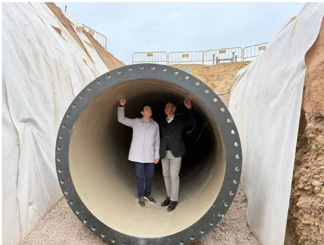
El concejal del Ciclo Integral del Agua, Carlos Mundina, y el CEO de Global Ómnium, Dionisio García, visitan las obras de La Presa en Manises
