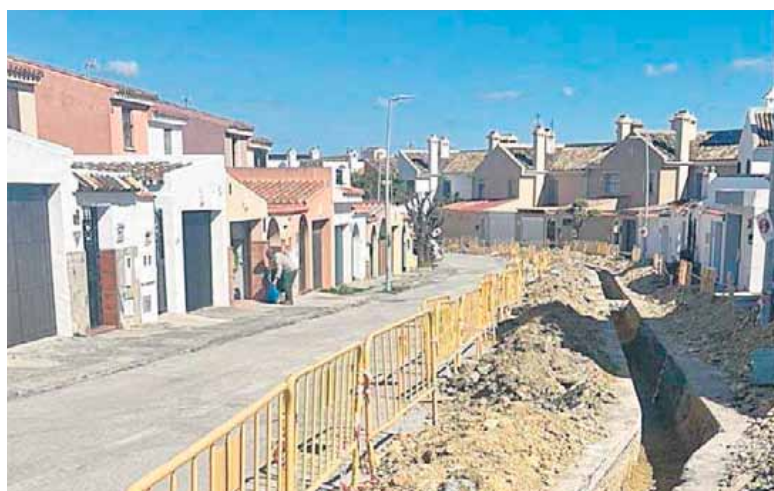
Obras en la red de abastecimiento en la barriada de San García.
